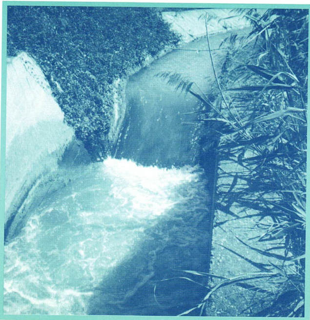
Final de la canalización de OPEL.
