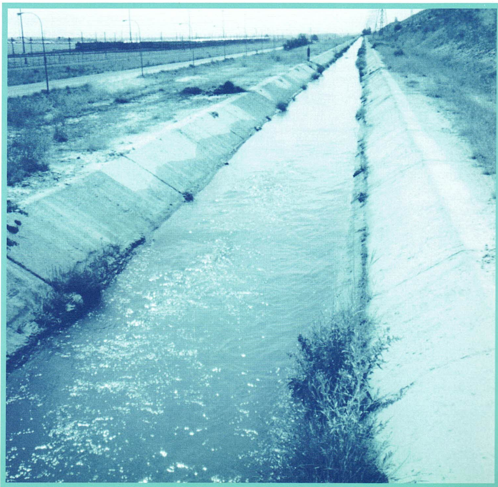
Canalización de la acequia en OPEL.
