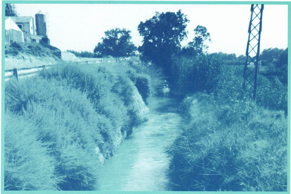
Tramo de Plasencia.
